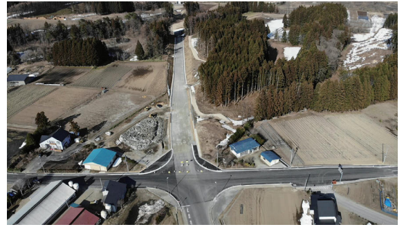
国道394号(榎林バイパス)工事(七戸町)
