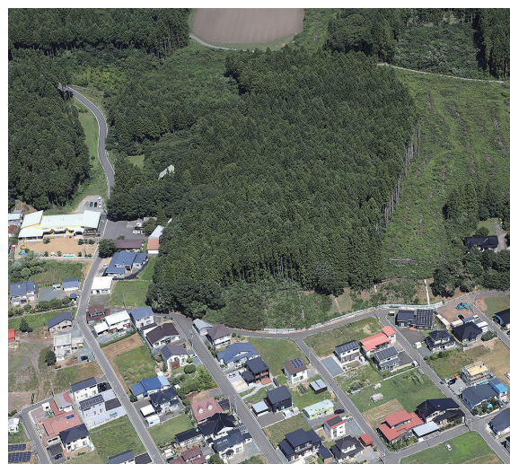
瓢2号区域急傾斜地崩壊対策事業（おいらせ町）
