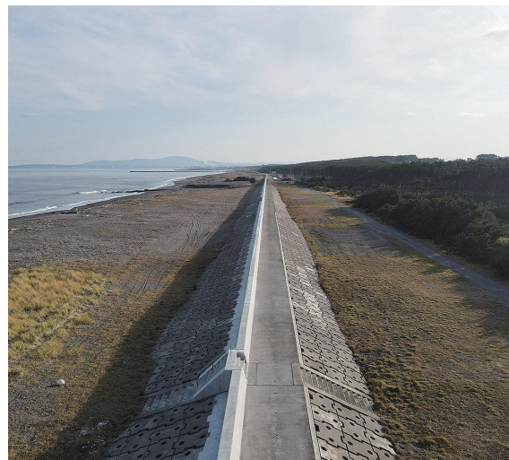
百石海岸津波危機管理対策緊急事業（おいらせ町）
