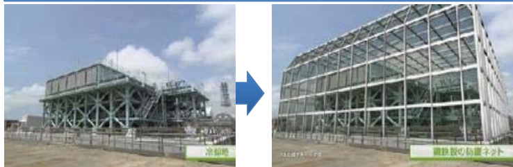
安全冷却水系冷却塔（左：工事前、右：工事完了イメージ）
