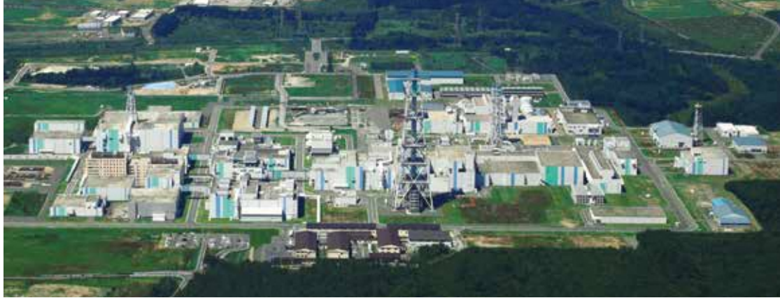
六ヶ所再処理工場
