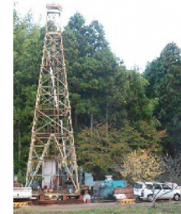
ボーリング調査(イメージ)
