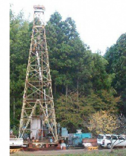
ボーリング調査(イメージ)
