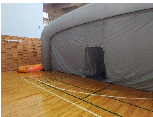
【可搬型エアテント（陽圧化可能）の設置】
