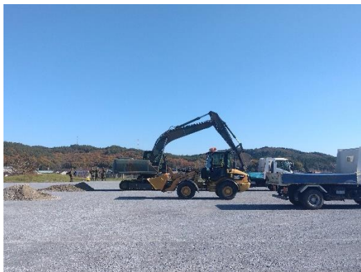
【青森県建設業協会下北支部及び陸上自衛隊の重機による啓開作業】
