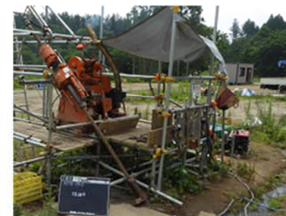
ボーリング調査の例
