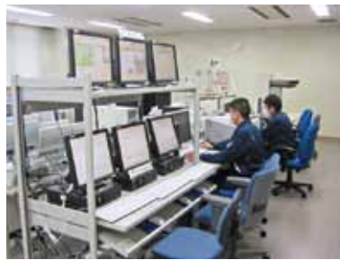
原子力センターテレメータ室
