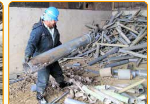
配管パイプなども運び込まれますが戸惑わず対応しています
