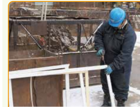
ごみの種類ごとに分別をするために解体作業を行います
