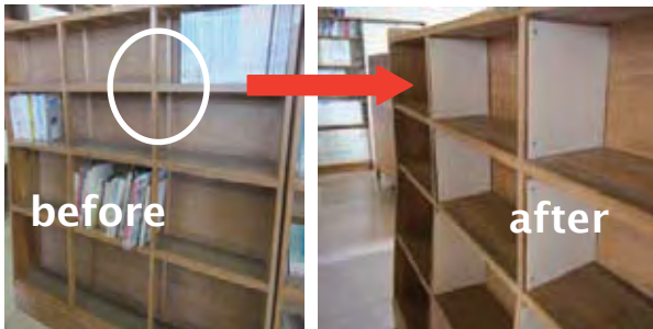
途中に仕切りがないため「筒抜け」の状態でした。
