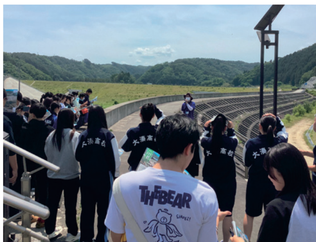
宮古市田老地区防潮堤
