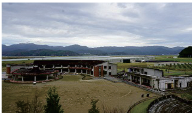
裏山から見る震災遺構大川小学校の全景
