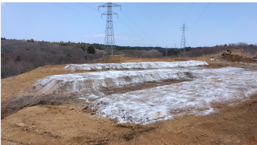
③2023. 3. 30 (11 時頃) 覆土及び消毒が完了した埋却地
