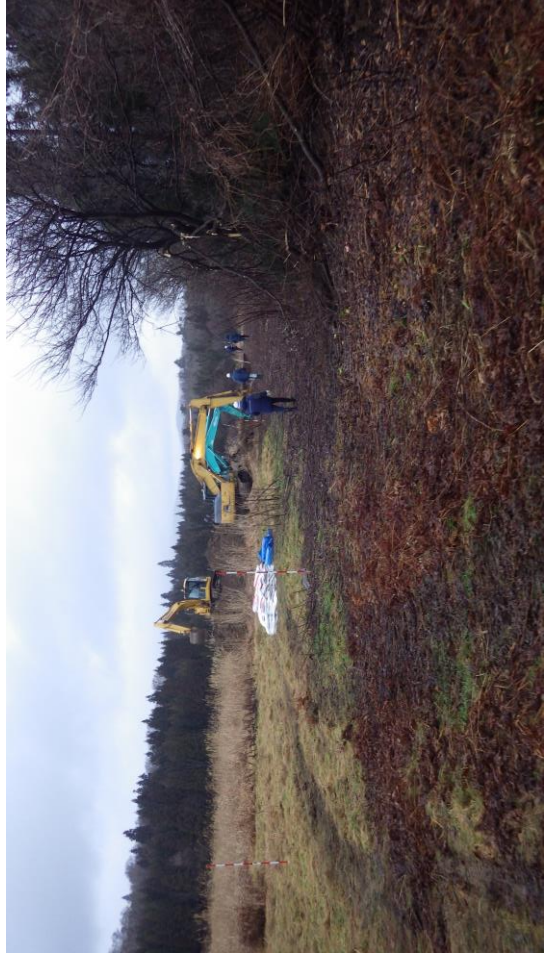
R03. 12. 12 掘削着工前
