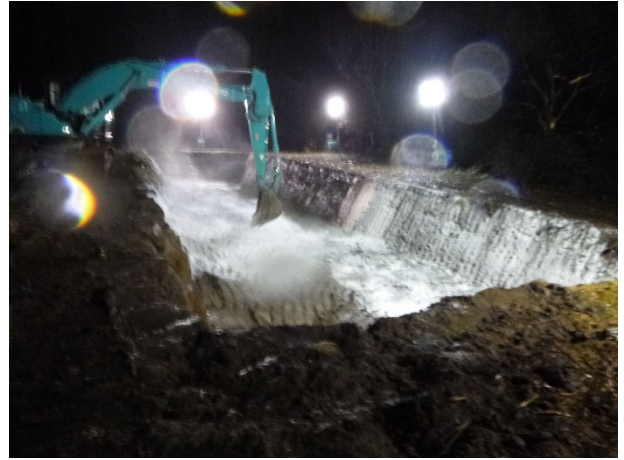
6. 底面・法面に消石灰散布
