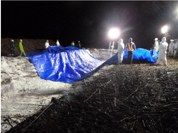
7. ブルーシートの敷設
