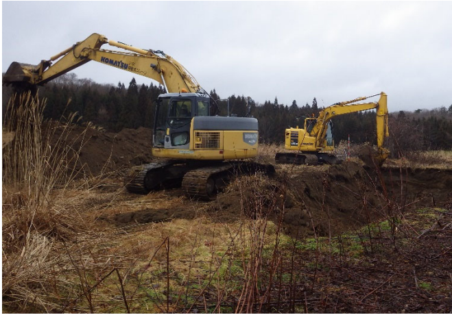
5. 埋却溝の掘削
