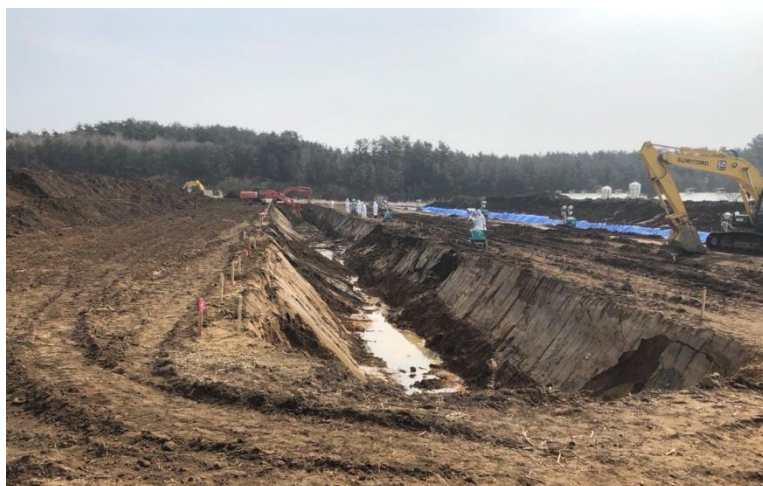
⑦2022. 4. 10 (10 時頃) 埋却溝 (二列目) の掘削状況
