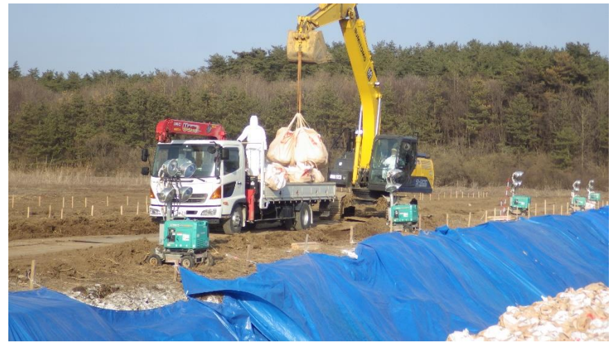
②2022. 4. 9 (16 時頃) フレコンバッグ投入状況(1)
