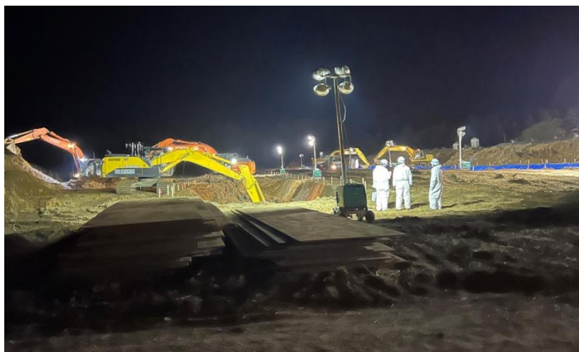
⑤2022. 4. 9 (22~23 時頃) 埋却溝 (二列目) 掘削状況 (2)
