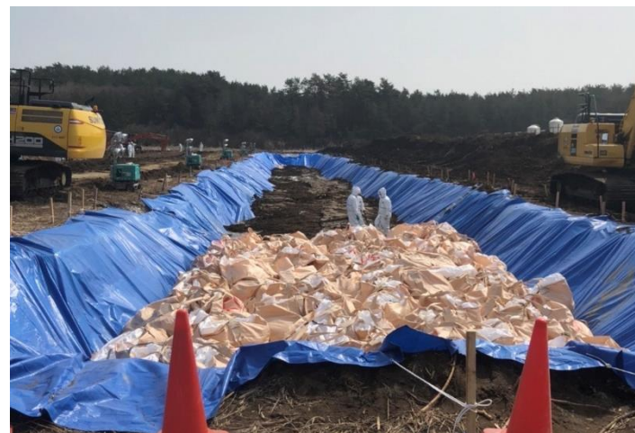
⑥2022. 4. 10 (10 時頃) 埋却溝 (一列目) の状況
