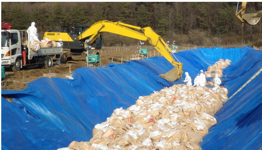
③2022. 4. 9 (16 時頃) フレコンバッグ投入状況(2)
