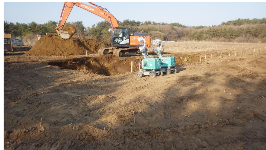
④2022. 4. 9 (16 時頃) 埋却溝 (二列目) 掘削状況(1)
