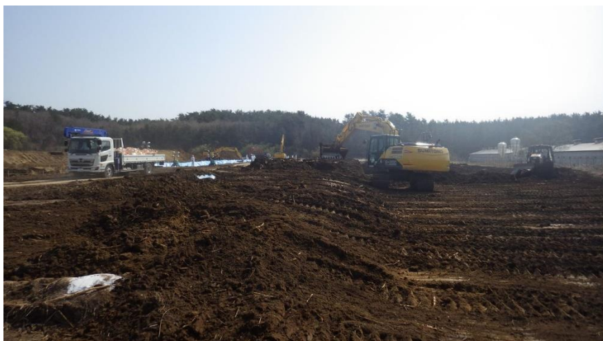
⑦2022. 4. 11 (8～9 時頃) 1 溝目 仮覆土完了
