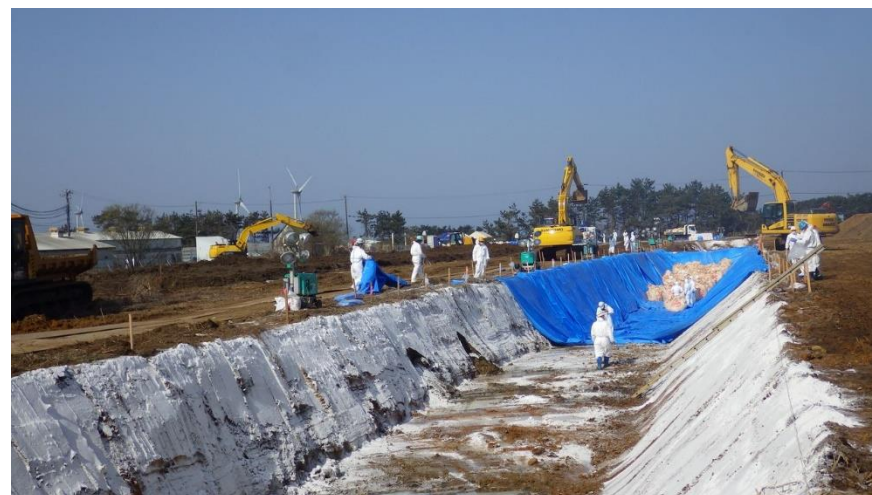
⑧2022. 4. 11 (8～9 時頃) 2 溝目 フレコンバッグ投入状況
