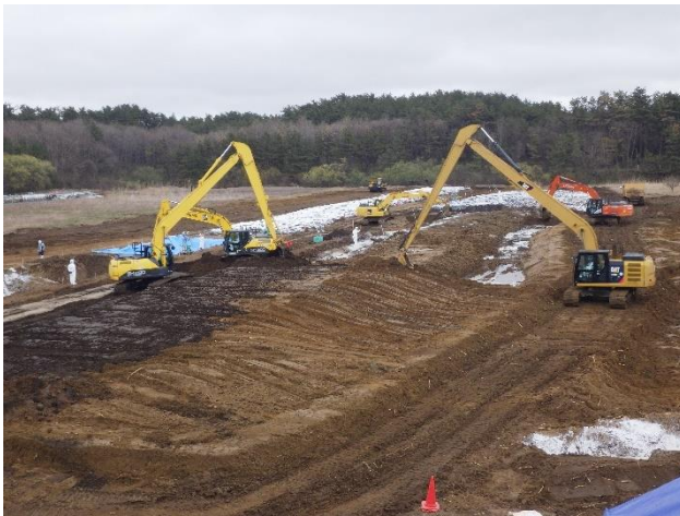
③0414 11時頃 (1例目) 埋却作業 (全景)
