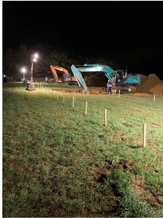
⑤0416 2時頃（2例目）埋却溝の掘削作業の様子（2）
