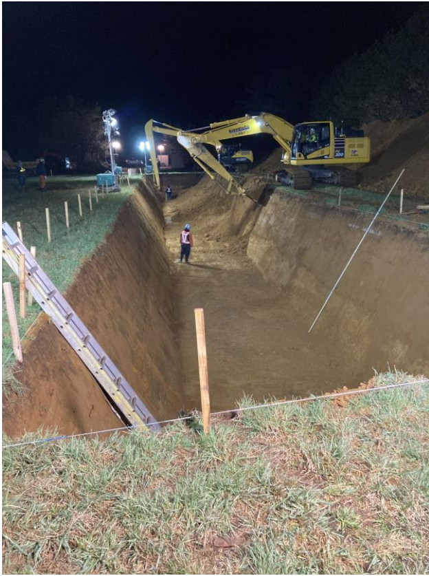
④0416 2時頃（2例目）埋却溝の掘削作業の様子（1）
