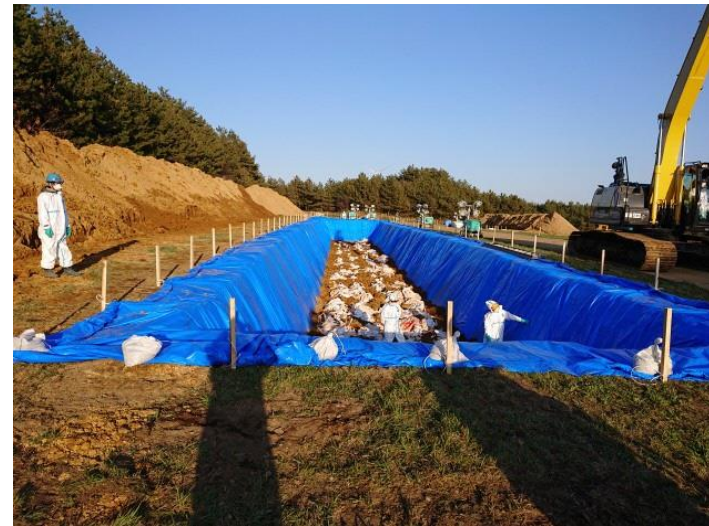
④0416 17 時頃_埋却作業の様子 (2)
