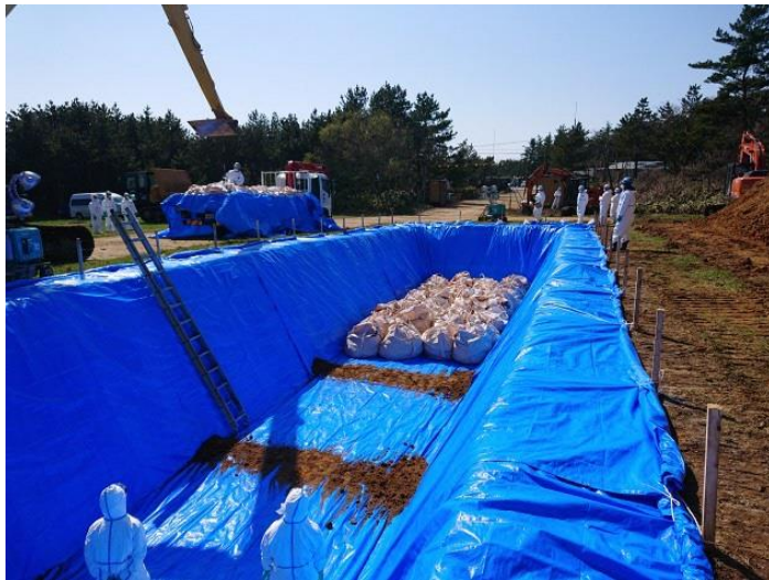
③0416 14 時頃_埋却作業の様子 (1)
