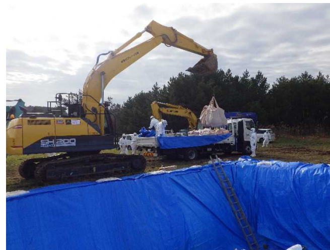
⑤2022. 11. 21 (13 時頃) フレコンバッグの投入 2
