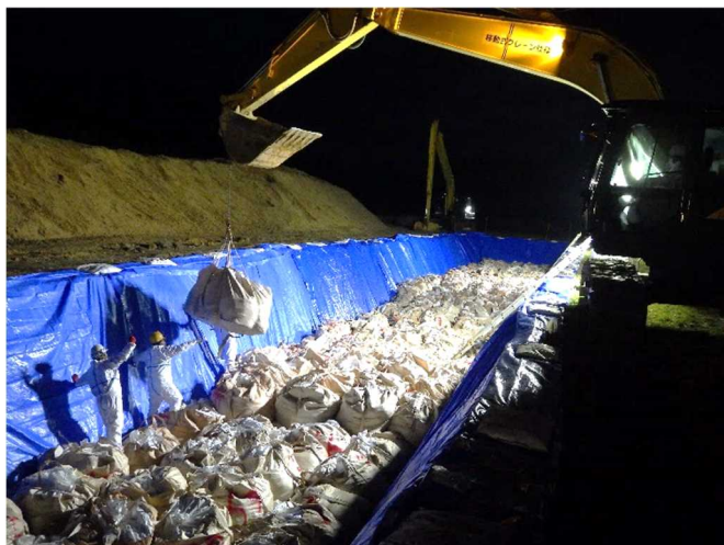
⑥2022. 11. 21 (17 時頃) フレコンバッグの投入 3
