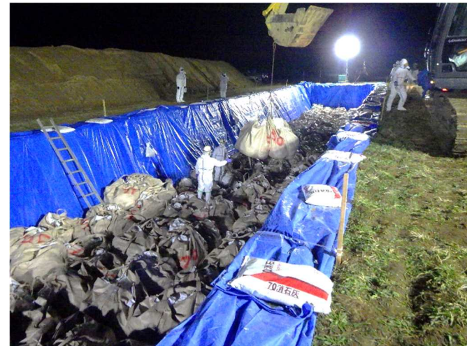
⑧20221123 (4 時頃) フレコンバッグの投入作業 (2 溝目)
