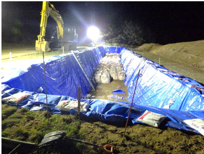
⑦20221122 (18 時頃) フレコンバッグの投入状況 (2 溝目)
