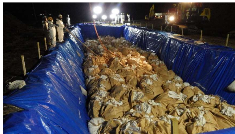
④2022. 12. 27 (1-9 時) 埋却作業の様子
