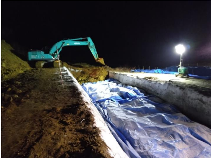
⑤2023.03.26（4時頃）埋却作業の様子1
