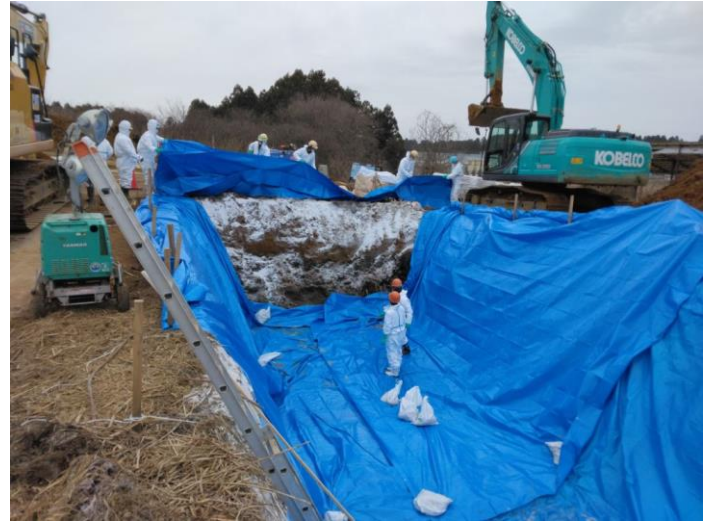
⑥2023.03.26（8時頃）埋却作業の様子2
