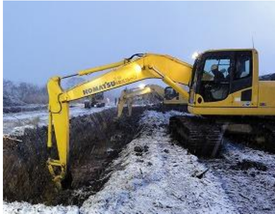
掘削などで使われる油圧ショベル
