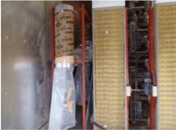
台車が通路に入った状態。台車が通路を遮断するが、下側をくぐり抜けることができるため、作業動線は確保される。
