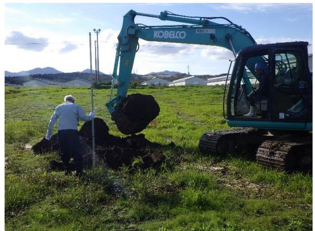
図8 埋却候補地の試掘
