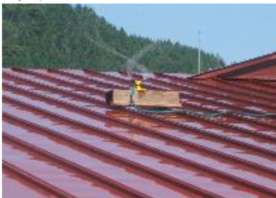
屋根への散水
