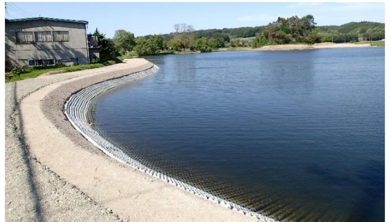
また、洪水や地震によって施設が破損した場合、下流農地や施設に甚大な被害が生じる恐れがあります。そのため、堤体の安全性を向上させることを目的に漏水箇所の改修や法面保護などの改修工事を行っています。
