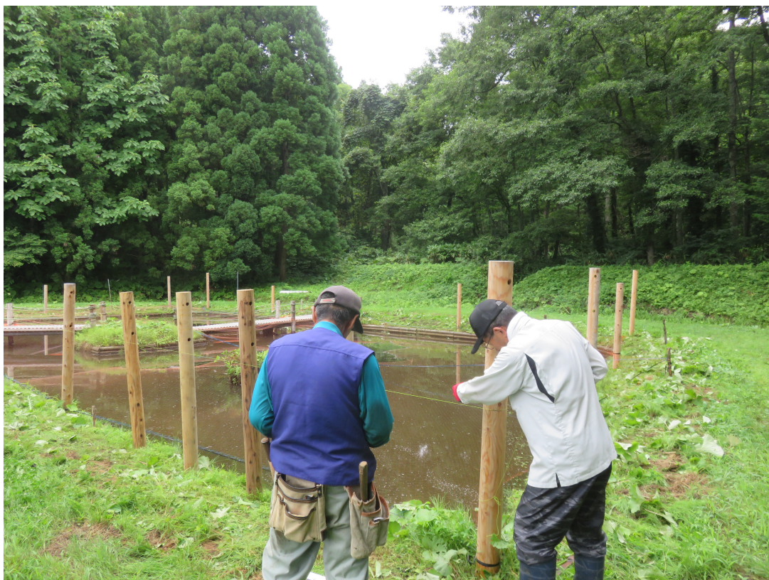
木杭を設置する様子
