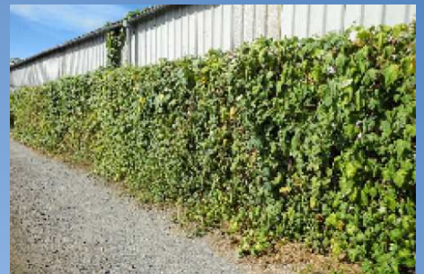
植物や遮光ネットの設置
