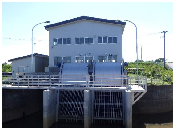
農業水利施設保全合理化事業 小田川南部地区 金木排水機場 (H27～R7)
