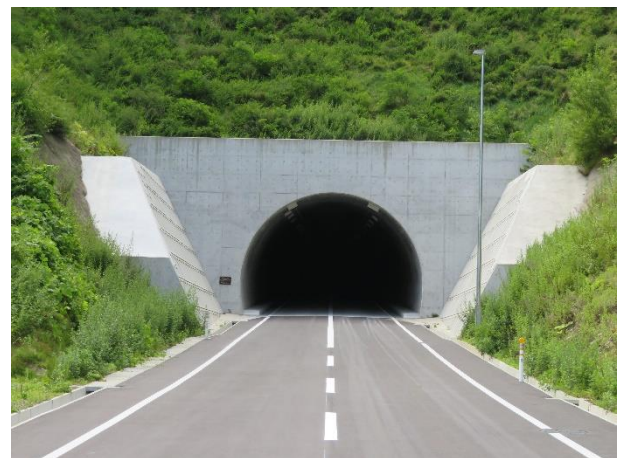
西海岸地区で整備した県内初の農道トンネル (亀杉トンネル)
