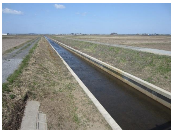
かんがい排水事業 岩木川左岸 3 期地区 (H20～H28)
