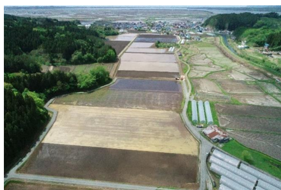
農地中間管理機構関連農地整備事業 (薄市飛石地区 中泊町 R3～R8)
