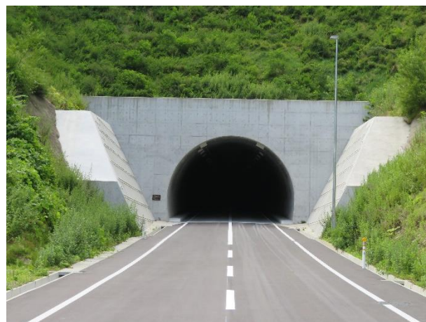
西海岸地区で整備した県内初の農道トンネル (亀杉トンネル)
