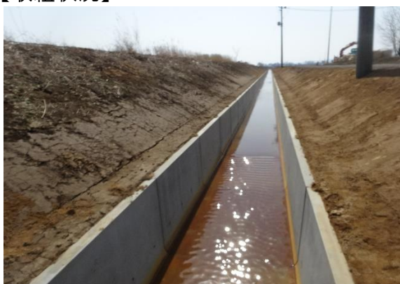
農業水路等長寿命化・防災減災事業 (水元排水路地区 鶴田町 R3～R6)
