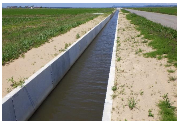
基幹水利施設ストックマネジメント事業 (車力排水路地区 つがる市 R3～R6)
