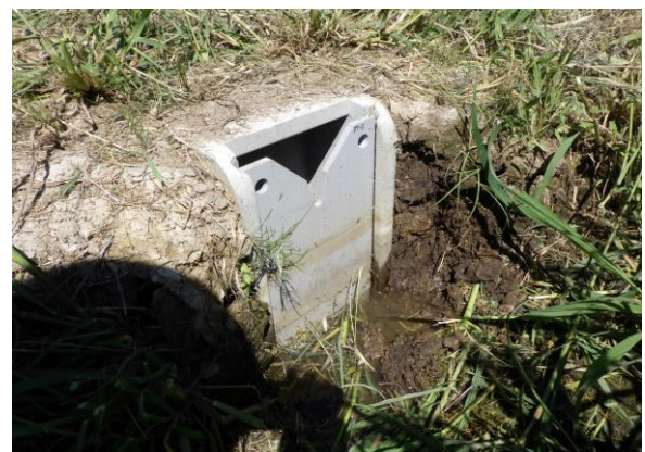
落水口に設置した堰板
