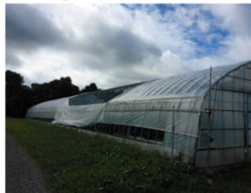
フィルムが破損 【引用・写真提供】 渡辺パイプ株式会社
