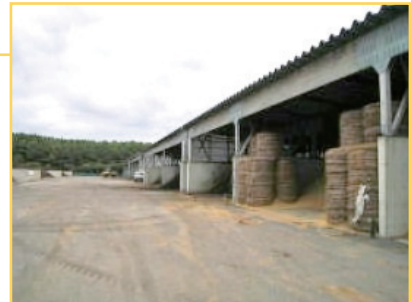
堆肥センター
