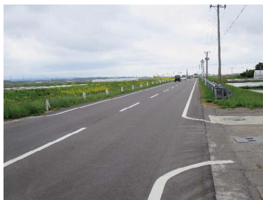
【保全対策後の農道】
