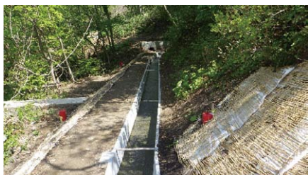
【農業用排水路】
