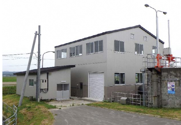
【改修後の排水機場】
