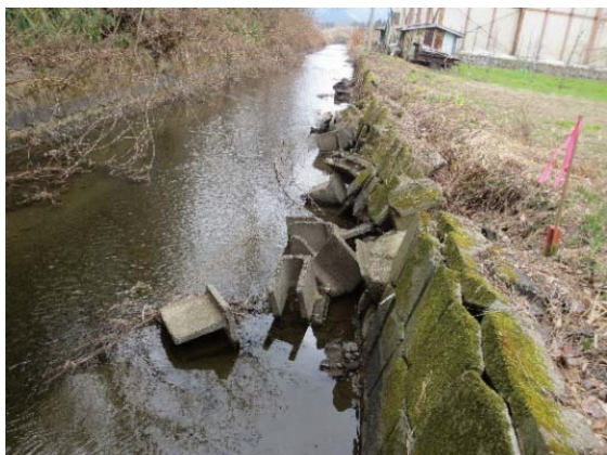
【整備前の用水路】
