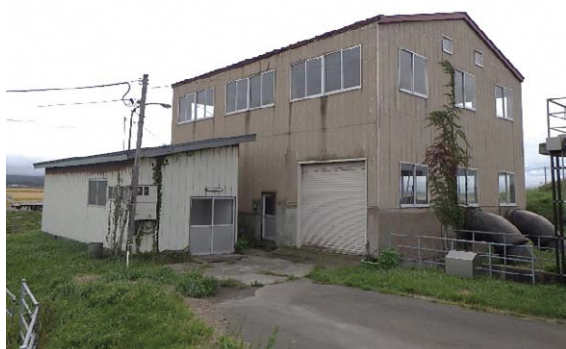
【改修前の排水機場】
