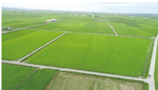
【ほ場整備により大区画化された水田】
