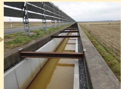
【L型水路による更新整備】
