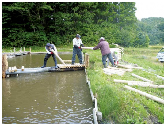
【ビオトープ池の木橋修繕(上小国地区)】
