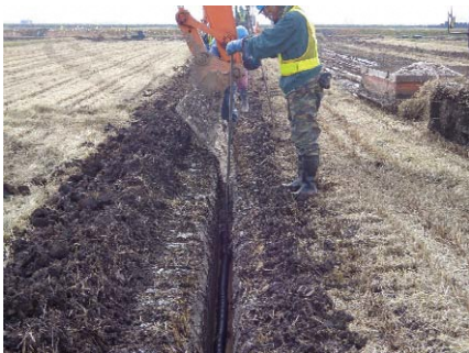
【暗渠排水の整備】
