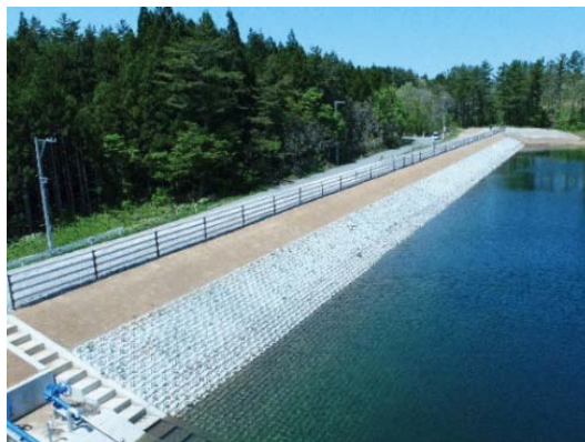
【対策後のため池】
