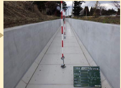
【パネル接着工法による補修】
