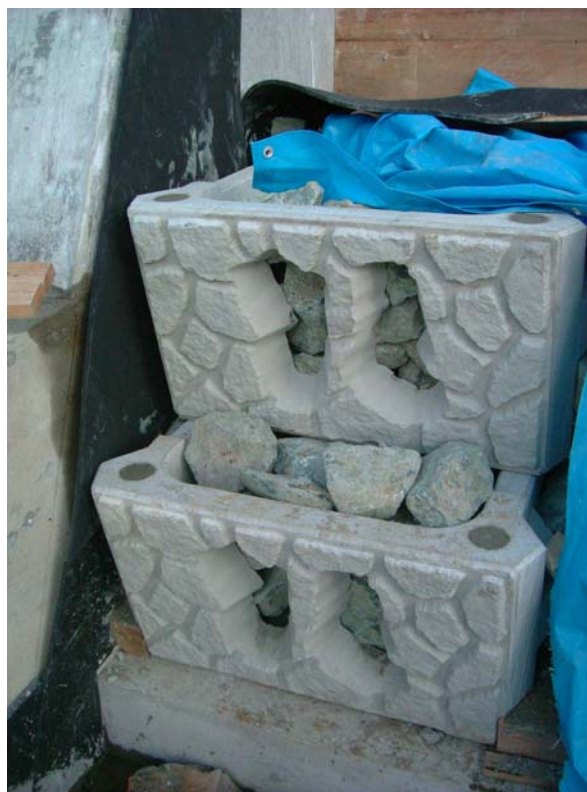
生態系保全に配慮した環境保全型ブロックで護岸工を施工
