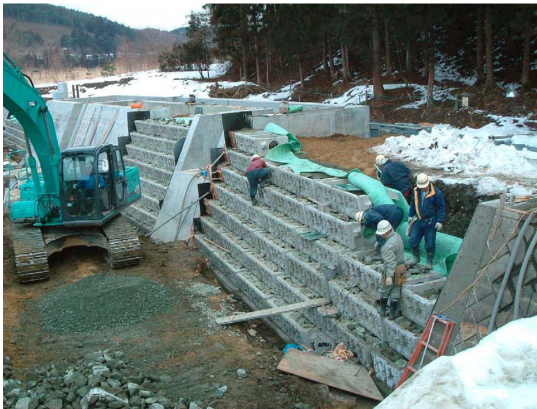
生態系保全に配慮した環境保全型ブロックで護岸工を施工
