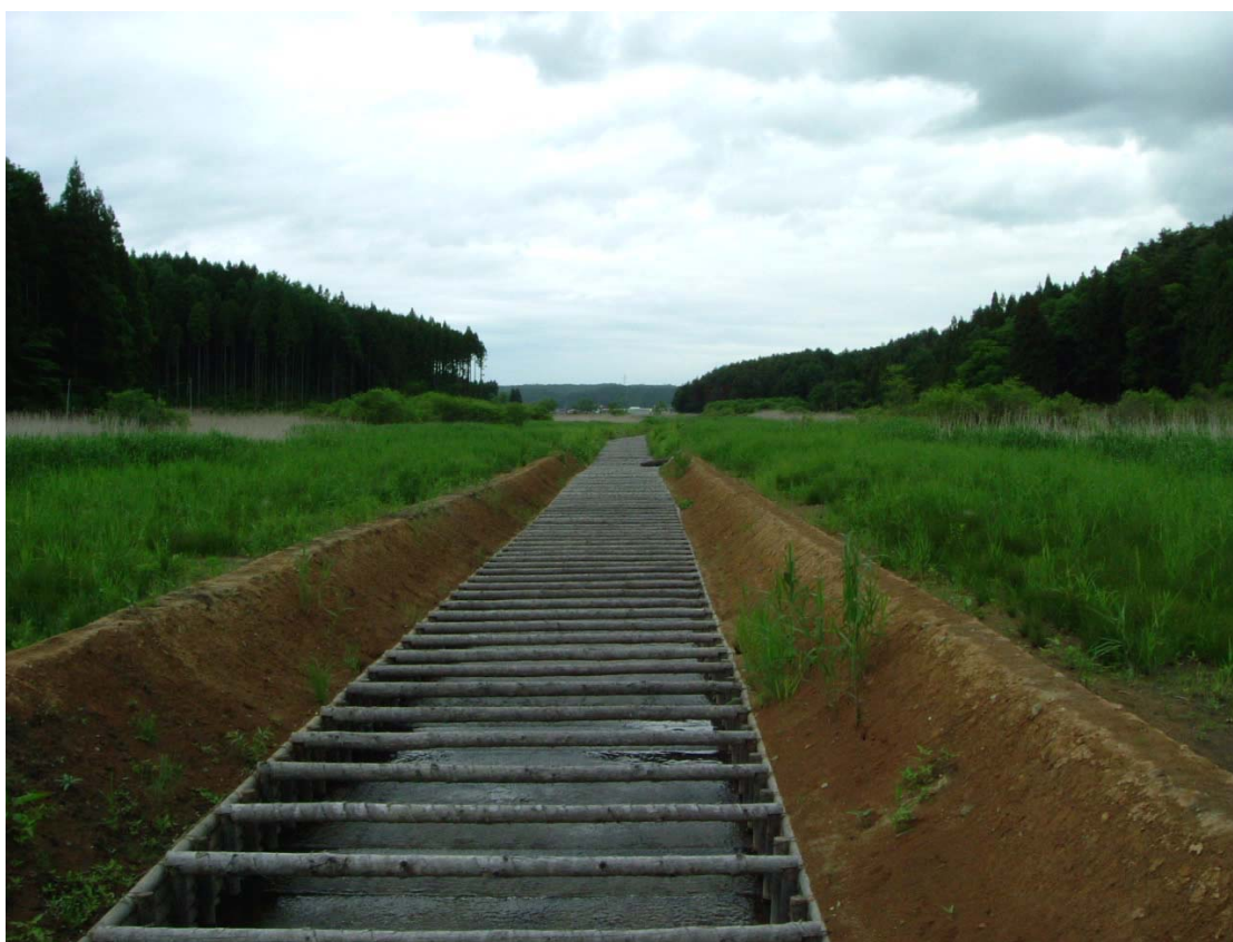
写真説明 木製流路工(二面丸太)
