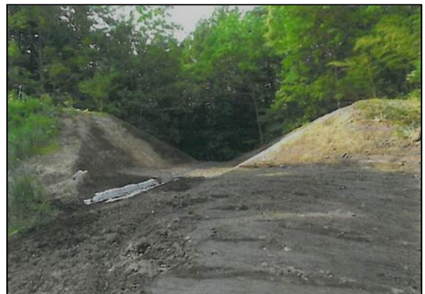
廃止のために堤体を開削した例
