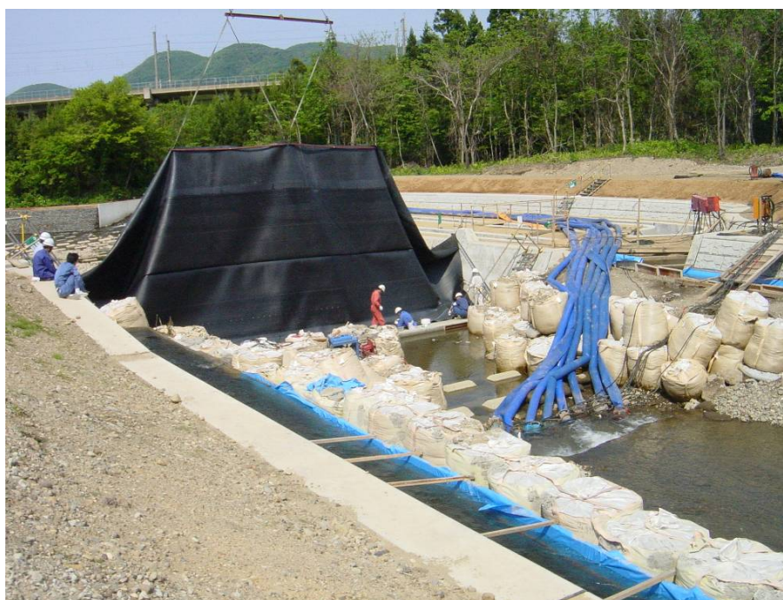
ラバーダム 設置状況
