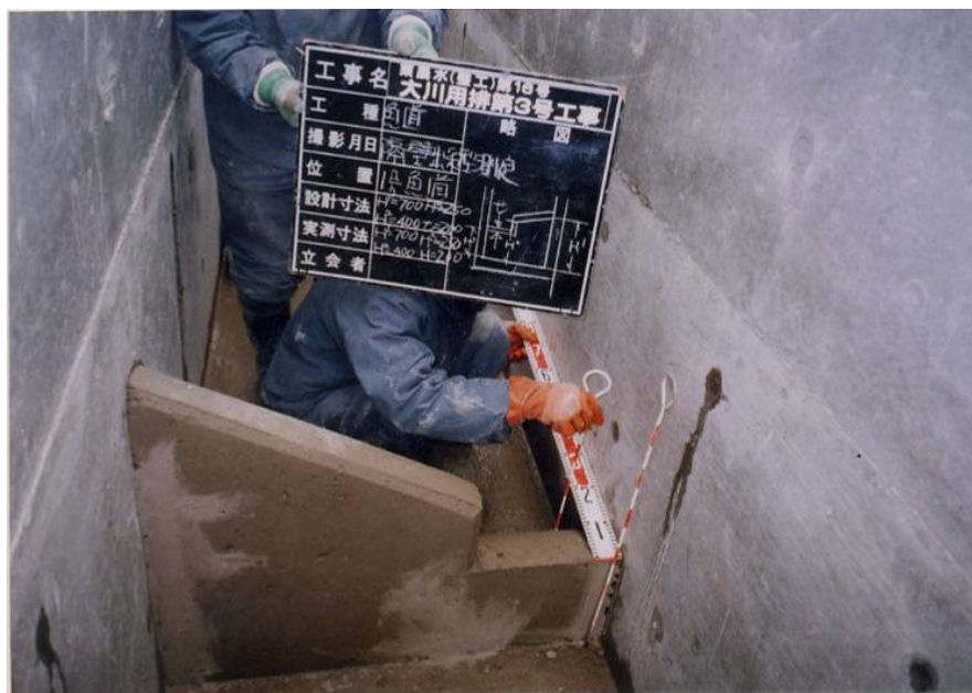
隔壁検測状況
