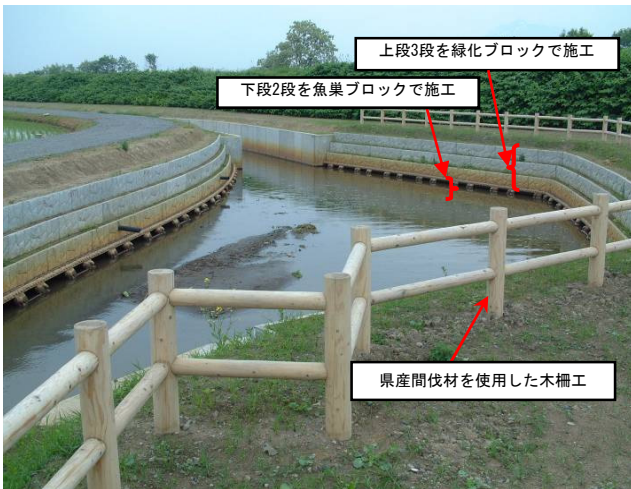
施工後4ヶ月後(H16.6.7撮影)
