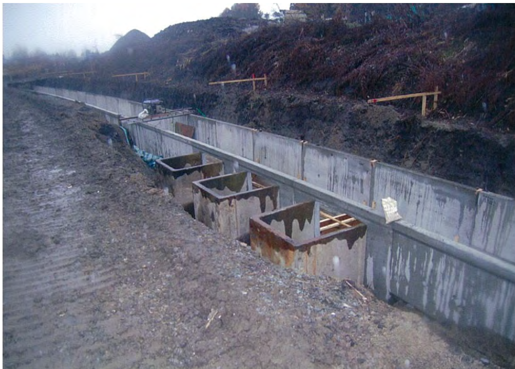
湾処 既設側溝取付状況
