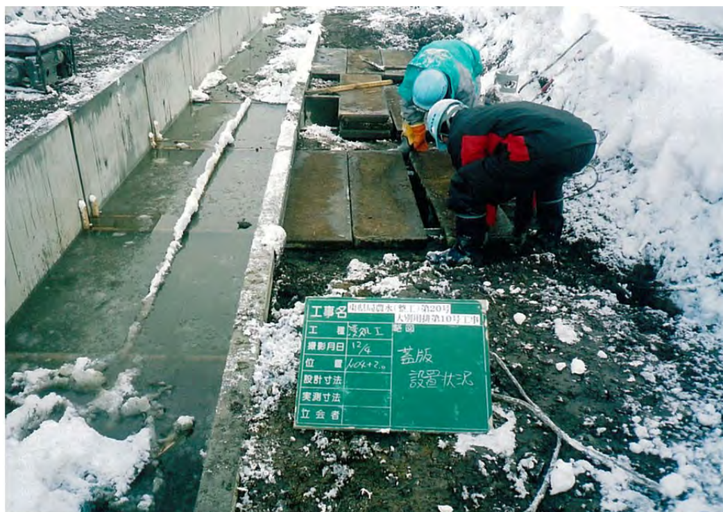
湾処 蓋版設置状況
