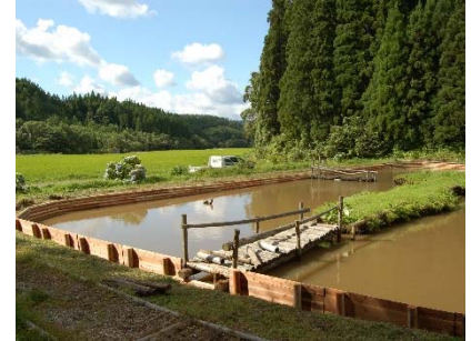
擁壁が整備されたビオトープ池
