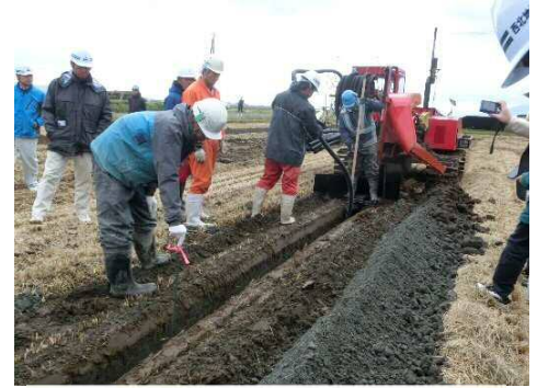
【暗渠排水の施工状況】
