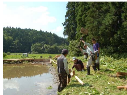
協議会による擁壁作りの様子
