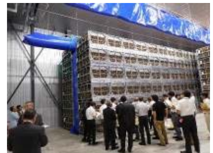
たまねぎ乾燥冷蔵施設内部（あわじ市）
