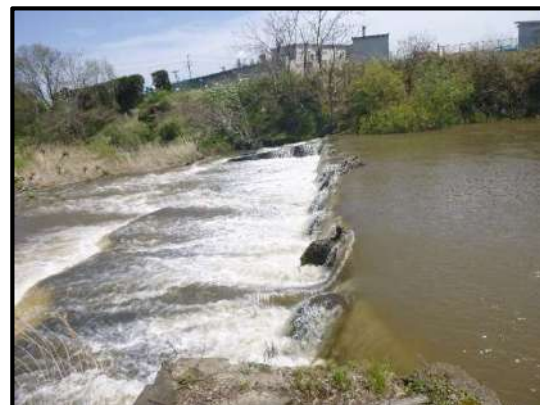
整備前の頭首工（沢田地区）
