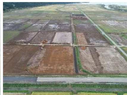
工事後（直線化した排水路）
