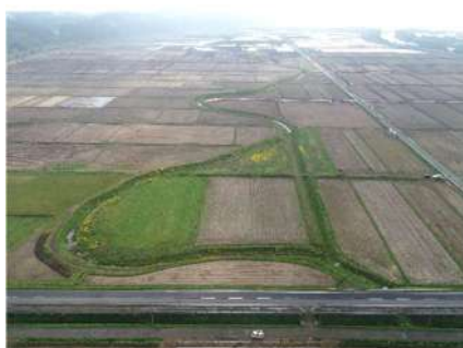
工事前（大きく蛇行する排水路）
