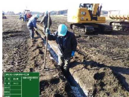
ホタテ貝殻を活用した暗渠排水の整備
