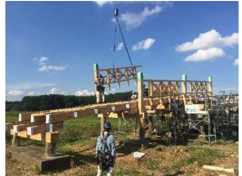
鶴の舞橋 改修工事の様子
