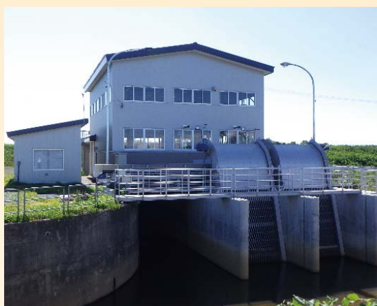
整備された排水機場 小田川南部地区（五所川原市）
