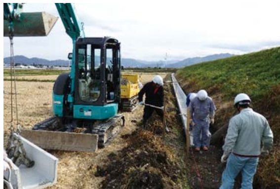
水路の更新 なんばいまつ 苗生松みどり会（平川市）
