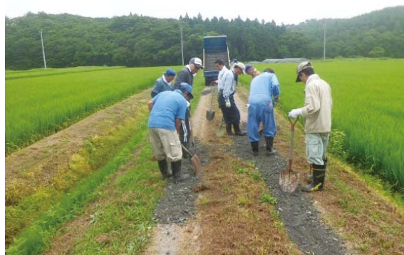
農道の砂利敷き みずがさわ 水ヶ沢農地保全の会（平内町）
