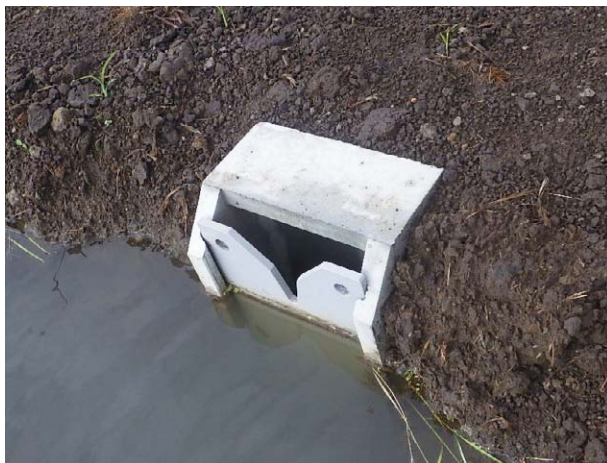
田んぼダム 流出量調整器具の設置状況
