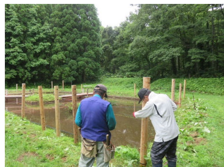
ビオトープ池への 転落防止柵の設置
