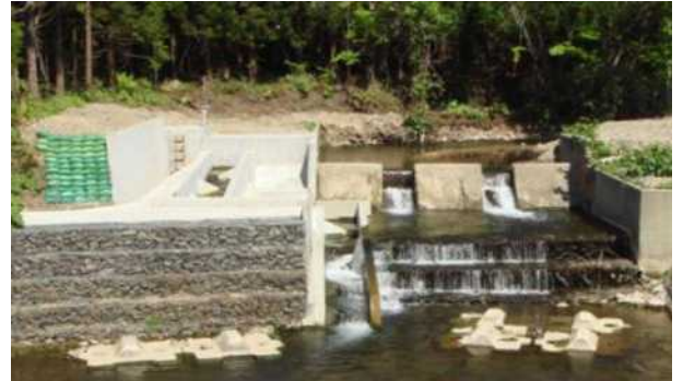
整備後の第3安兵衛頭首工(魚道は左～真中)
