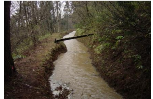
改修前の水路
