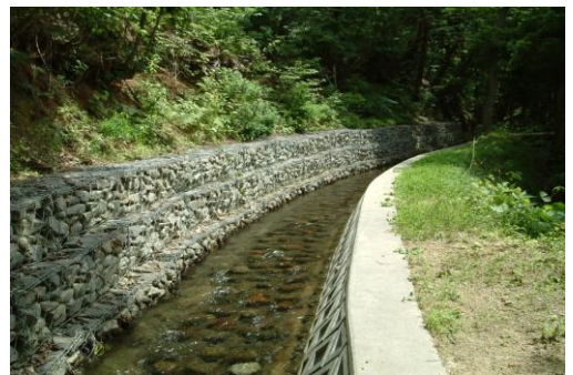
改修後の水路 (水路の底に石を配置)
