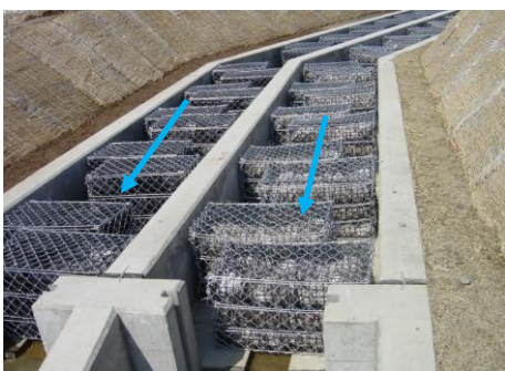
接触ろ材の設置
