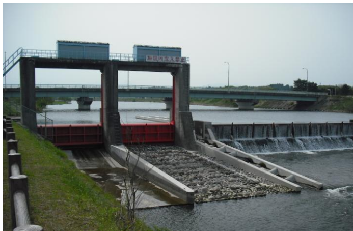
魚道が整備された藤坂頭首工
