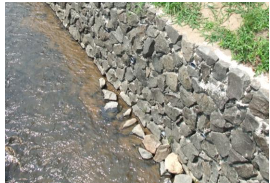
石積水路への改修
