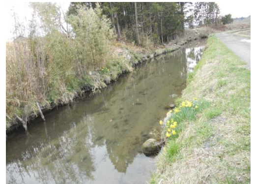
【整備前の水路】
